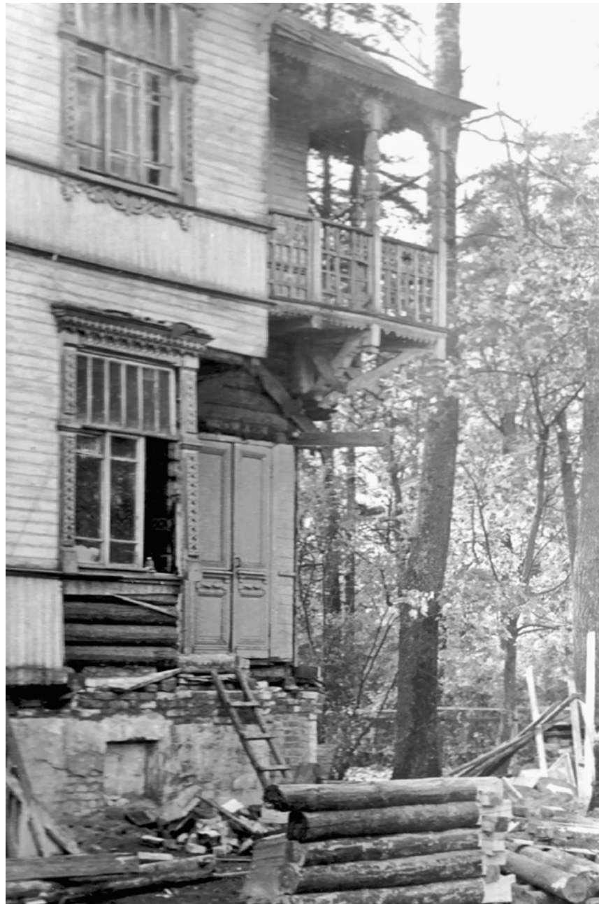
Фото 20. Замена сгнивших несущих конструкций Дома.
