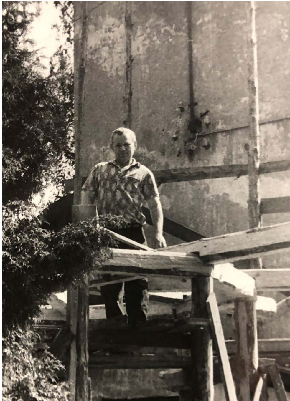
Фото 14. Анатолий Синников на ремонтных работах водонапорной башни.
