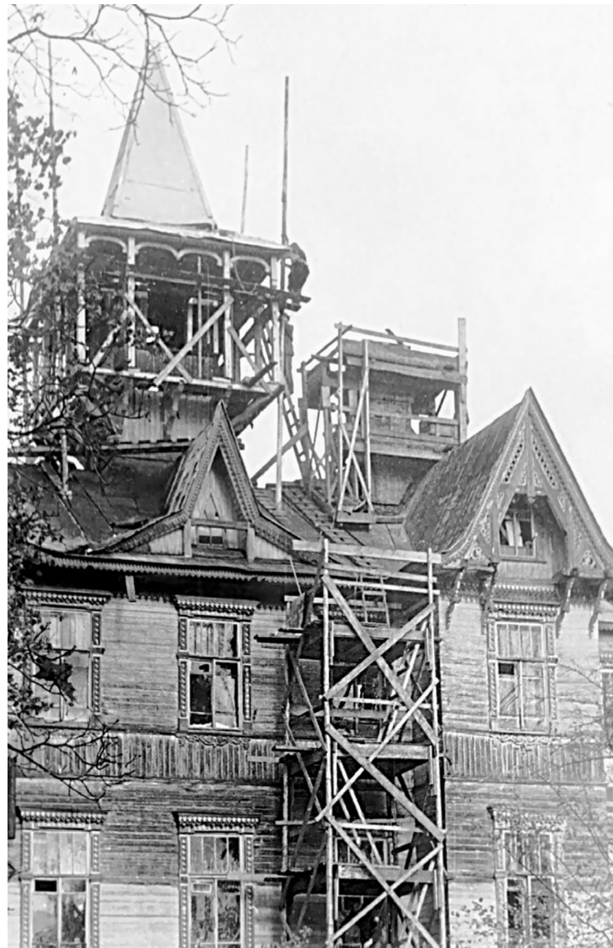
Фото 5. Работы по восстановлению башни.
