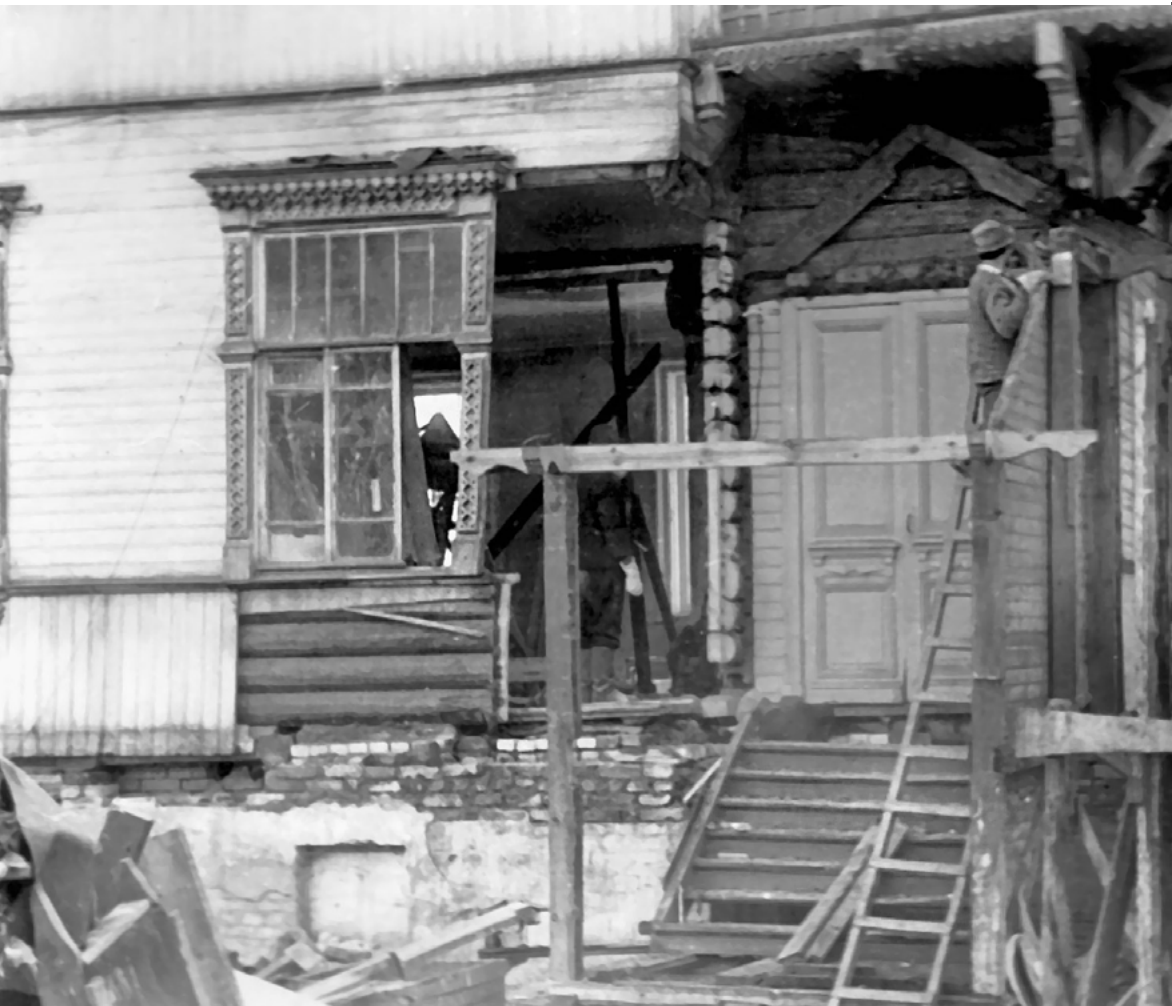
Фото 22. Сложные работы по замене несущих конструкций стен Дома.
