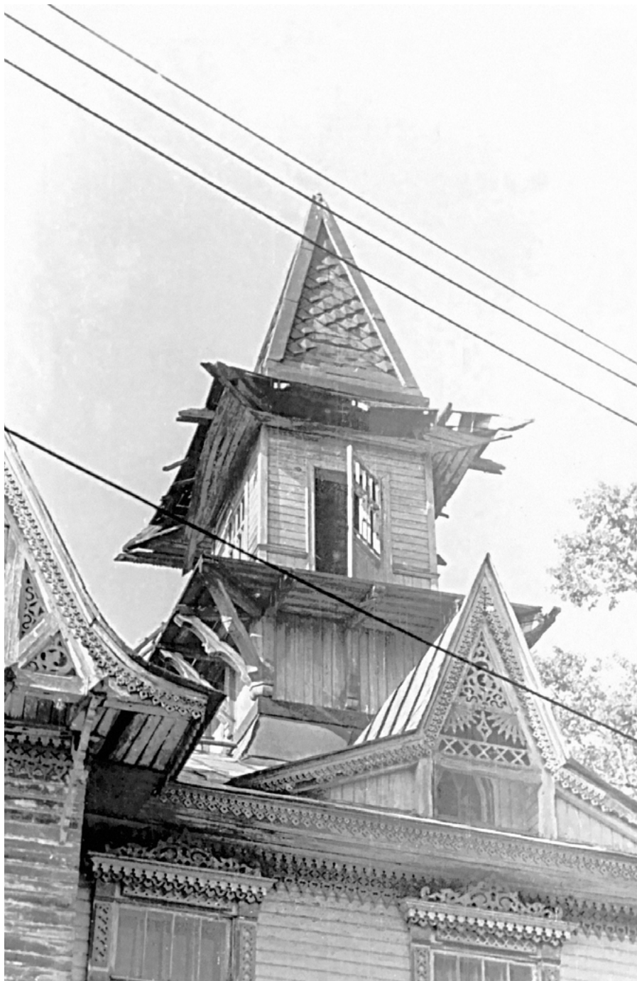
Фото 4. Башня на крыше Дома (июль 1989 г.).
