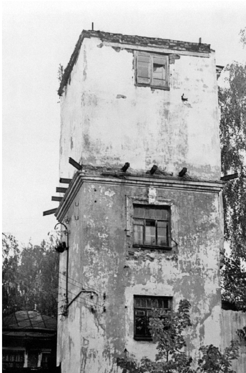
Фото 2. Водонапорная башня на территории Дома - 1989 г.
